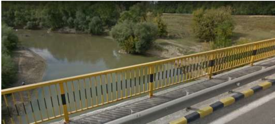
Subtraversarea Raul Ialomita, conducta de aducțiune și conducta de canalizare.
