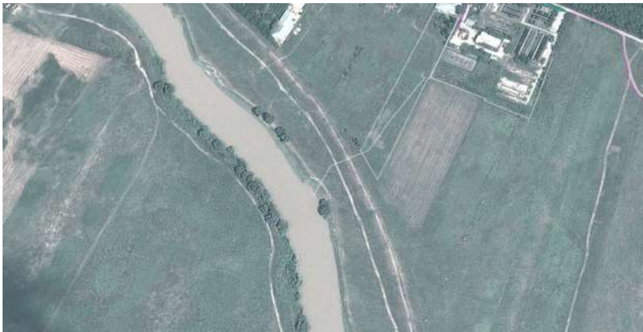
Amplasament gura de varsare apa epurata de la SEAU Urziceni
