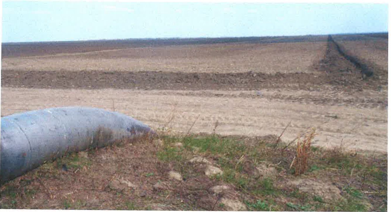
Imagine 9 Tronson 7 Traversare canal irigatii UAT Dor Marunt
