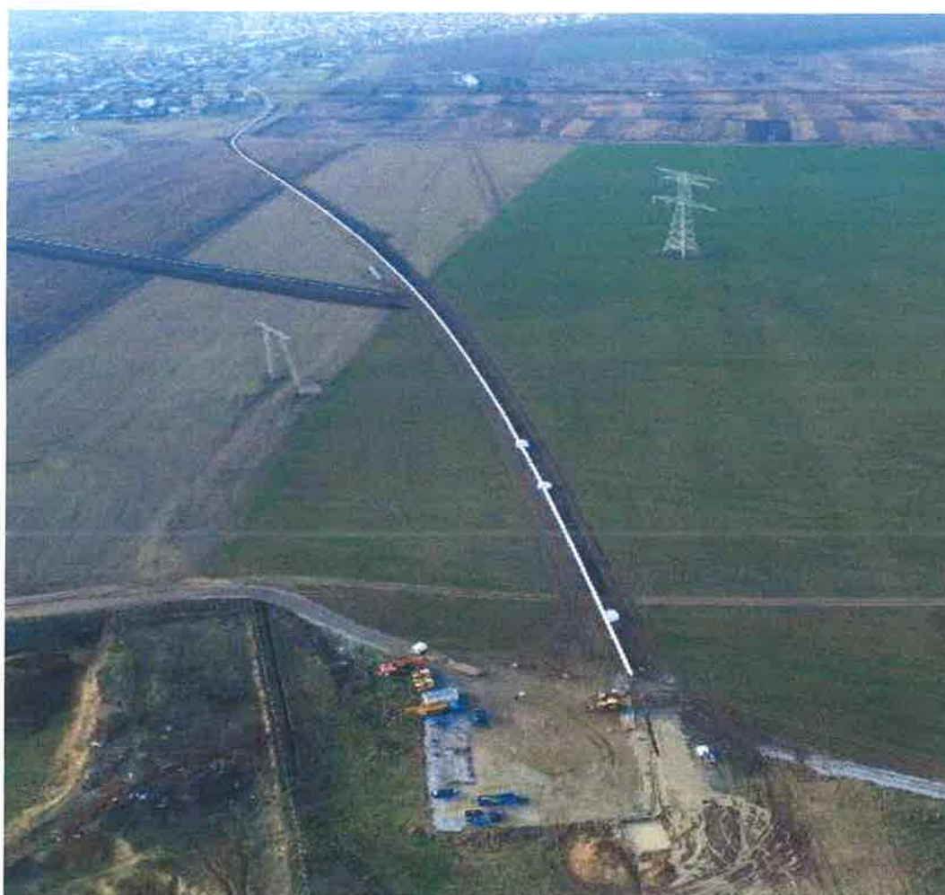
Imagine 4 Poziționare conductă înainte de tragere
