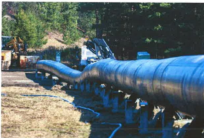
Imagine 2 Conducta produs montată pe role
