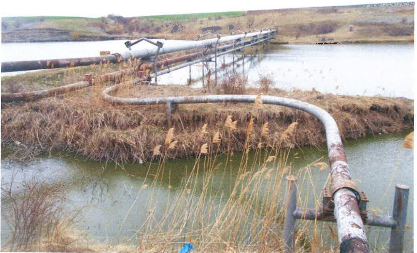
Imagine 12 Tronson 13- Estacadă metalică amplasată în zona amenajare piscicolă râu Vânăta.
