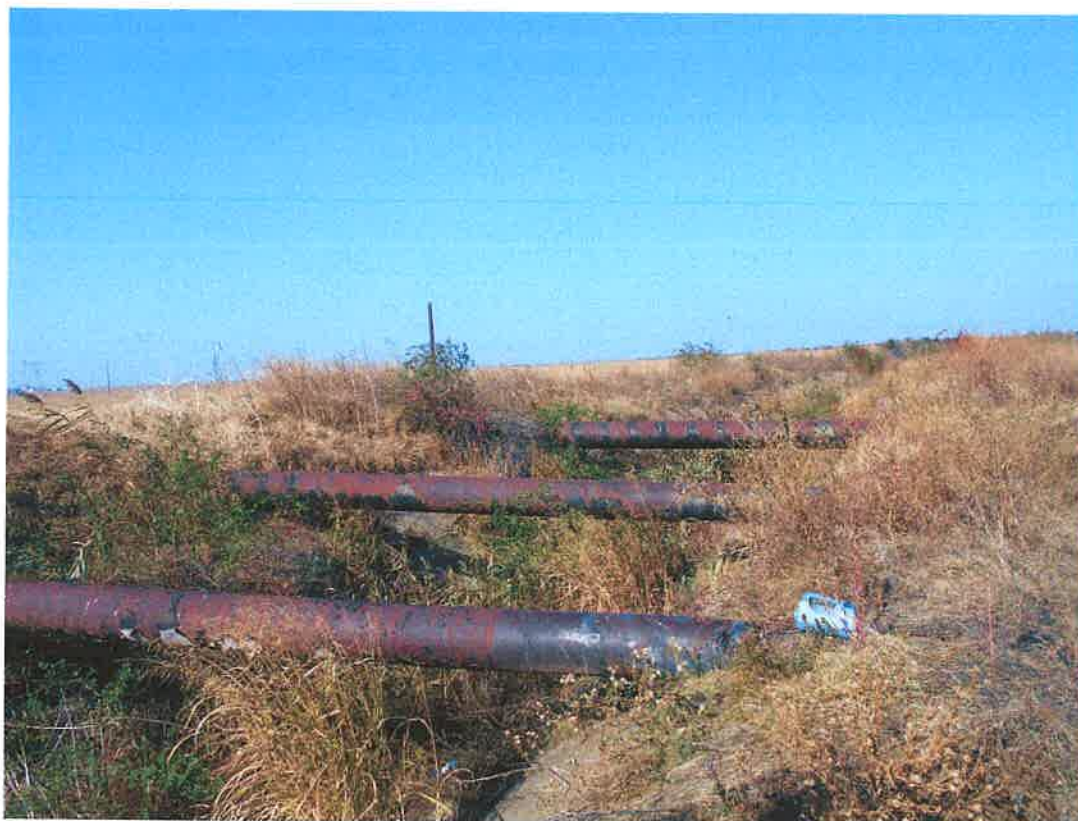
Imagine 6 Tronson 2- UAT Dragalina - Traversare canal irigație
