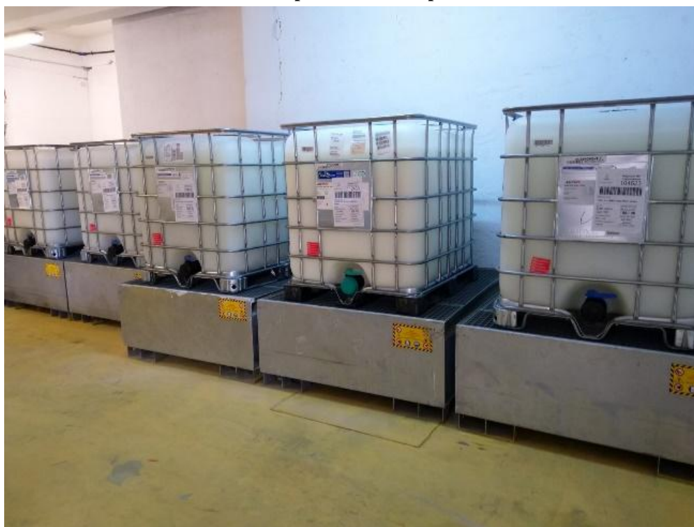
Referinta 23: Stocare substance chimice periculoase in depozitul de chimicale
