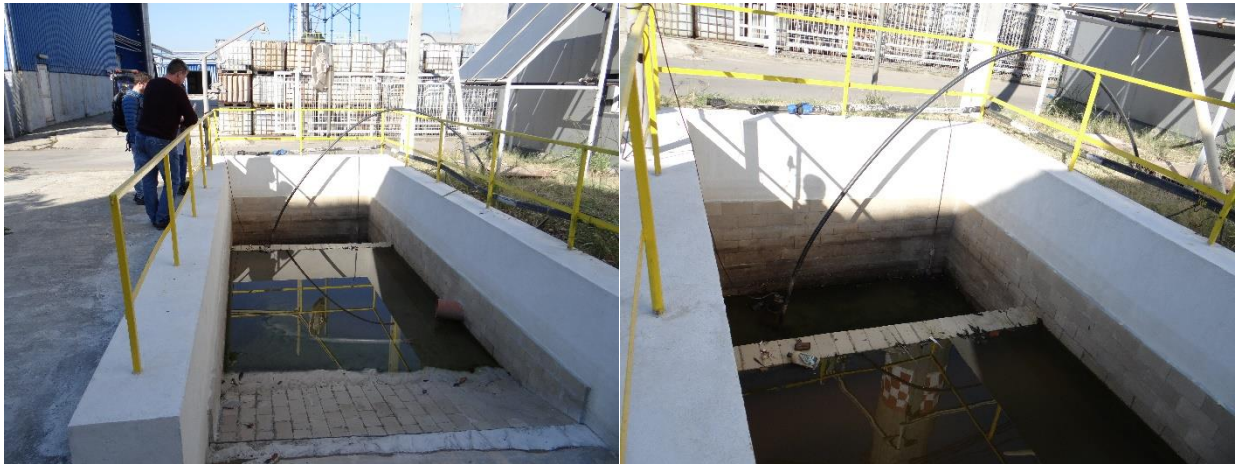
Figura nr. 2-12 Bazin decantor bicompartimentat
