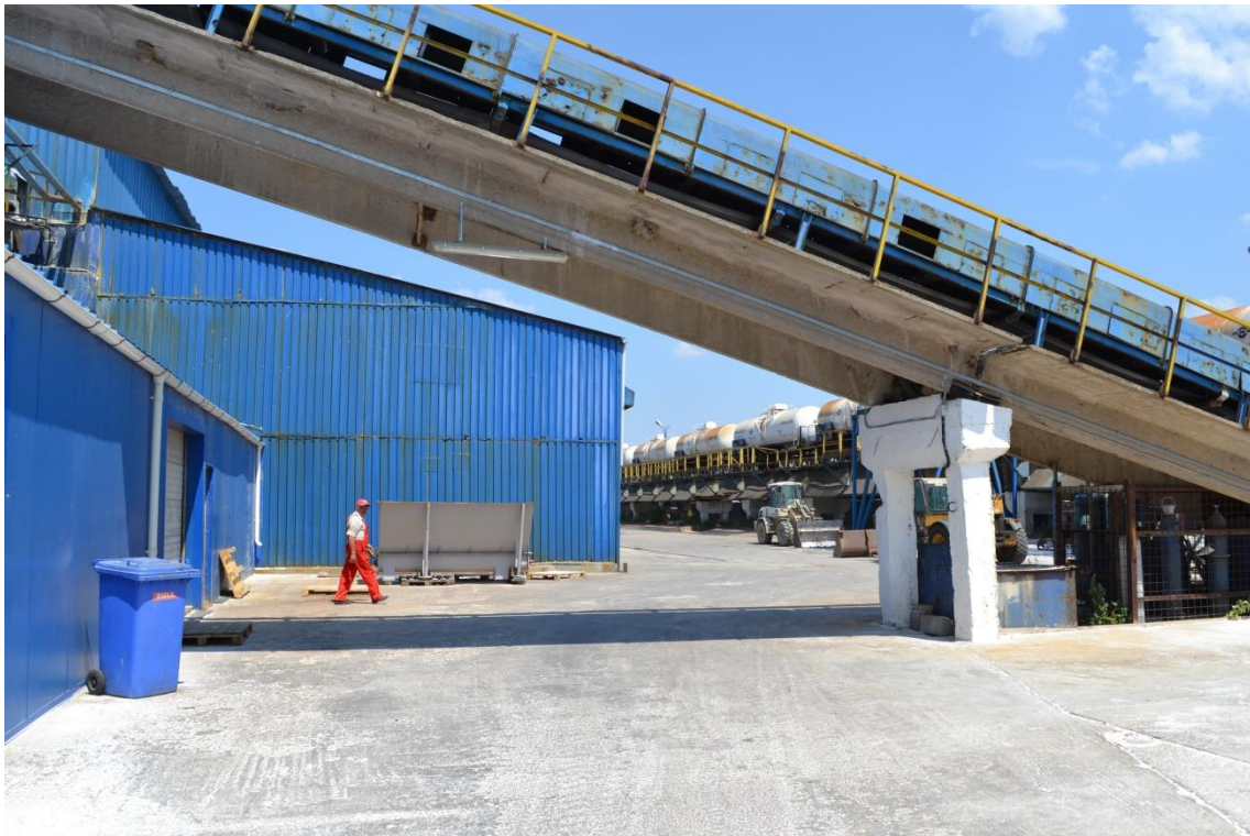
Figura nr. 2-4 Estacadă cale ferată și banda transportoare
