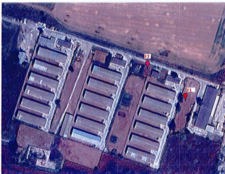
Fig.13 – Foraje de alimentare cu apa
