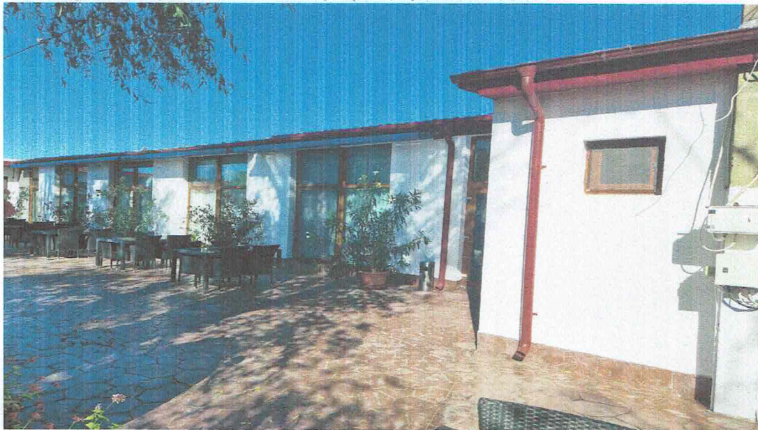
Fotografie Corp C10 constructie propusa spre desfiintare :
