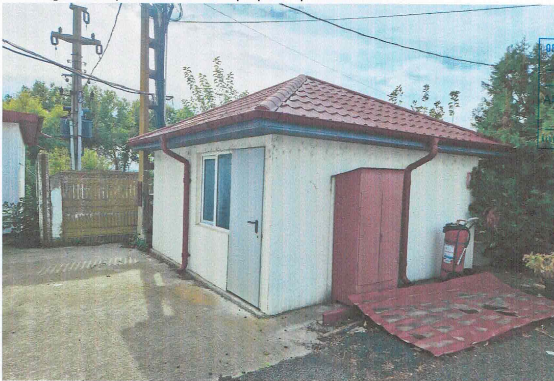
Fotografie Corp C12 constructie propusa spre desfiintare :
